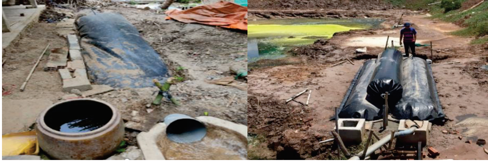
Hình 6. Mô hình túi ủ biogas HDPE nạp nguyên liệu thực vật kết hợp với chất thải chăn nuôi gia súc (trái) và chất thải nuôi tôm siêu thâm canh (phải)
